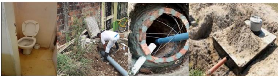
Excusado conectado a pozo ciego
